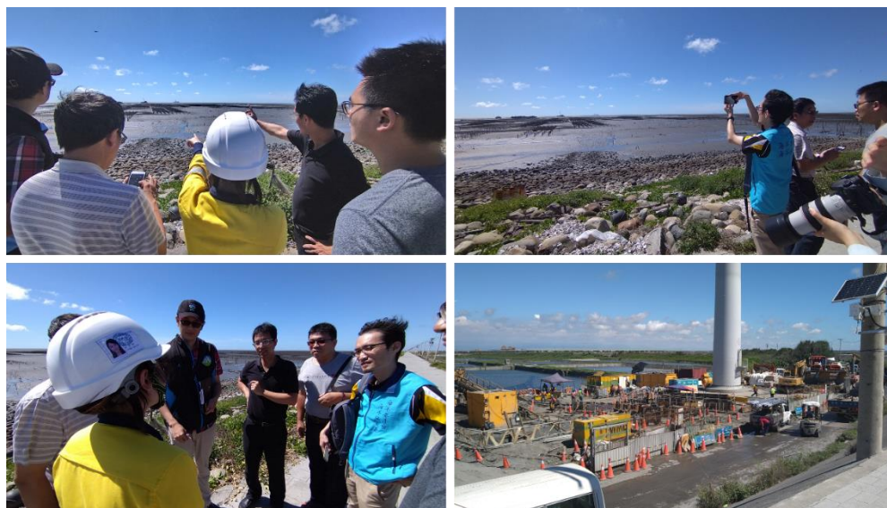
圖 3.1.3-5 訪查彰化大城海堤之海陸纜轉接段工程(TJB)施工處
