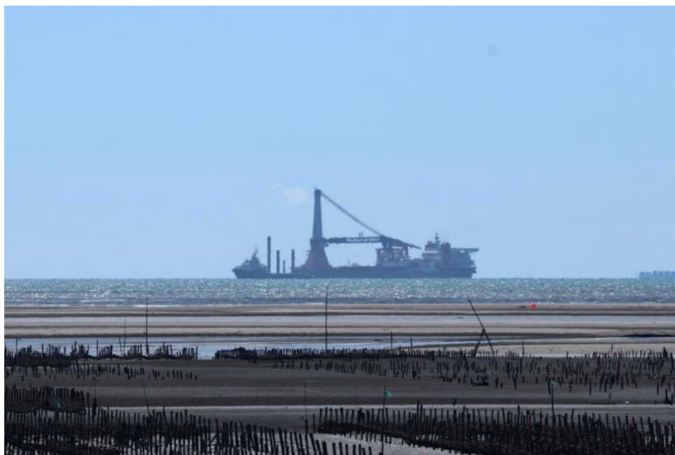
圖 3.1.3-6 由海陸纜轉接段工程(TJB)施工處拍攝海上施工處
