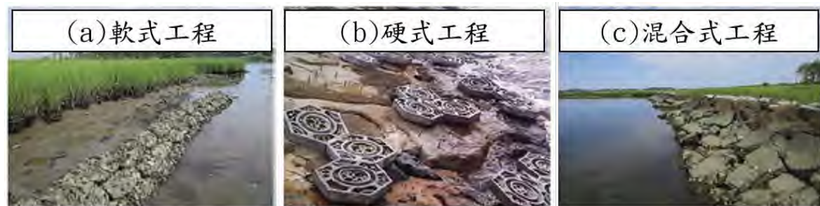
圖 6、常用的生態工法包含（a）軟式工程（牡蠣礁和鹽沼，美國乞沙比克灣）、（b）硬式工程（海牆磚，新加坡樟宜）和（c）混合式工程（石塊和鹽沼混合，美國乞沙比克灣）（Hawkins et al., 2019）。
