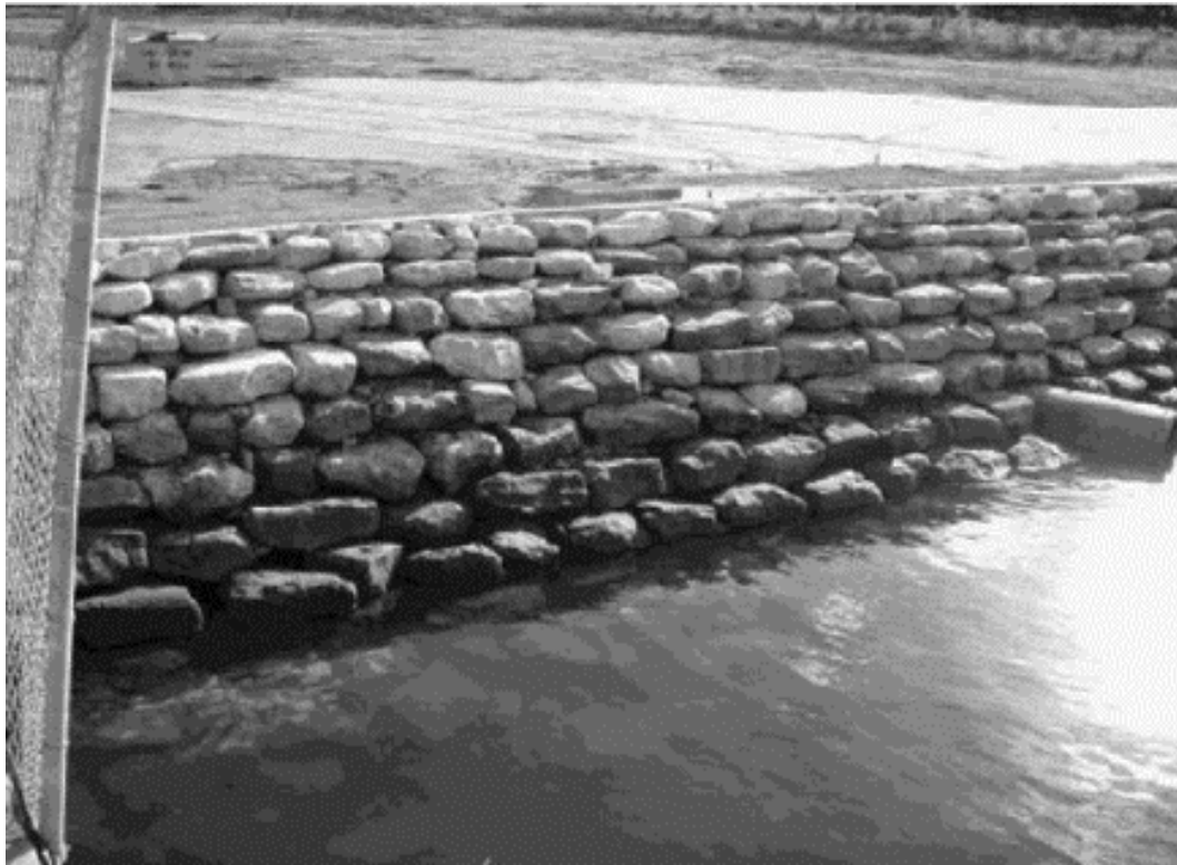
圖 7、以小石塊堆疊改變海牆坡度（Chapman and Underwood, 2011）。
