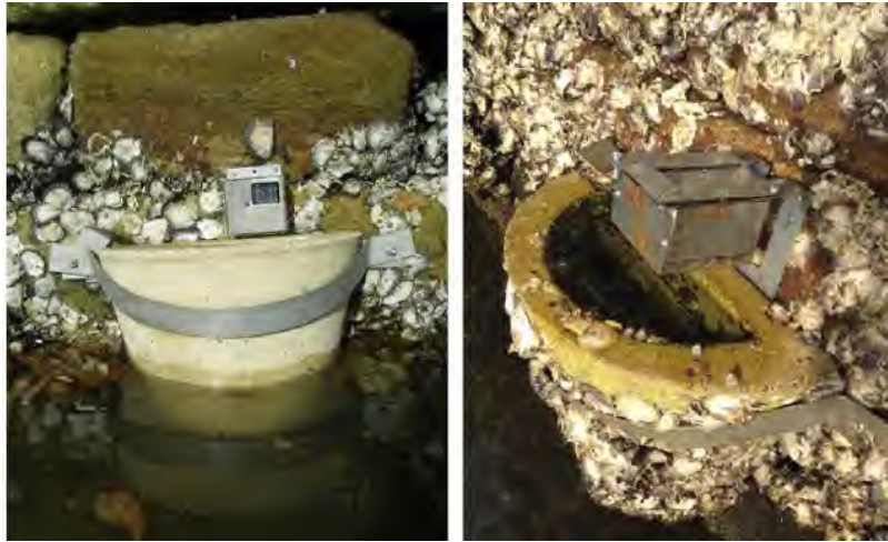
圖 9、海牆上裝置的花盆狀結構物 (Morris et al., 2017)。
