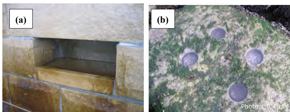
圖 8、（a）在海牆上設計模擬天然岩礁岸的潮池（Bulleri and Chapman, 2010）。（b）消波塊上鑿出的潮池（Firth et al., 2014）。
