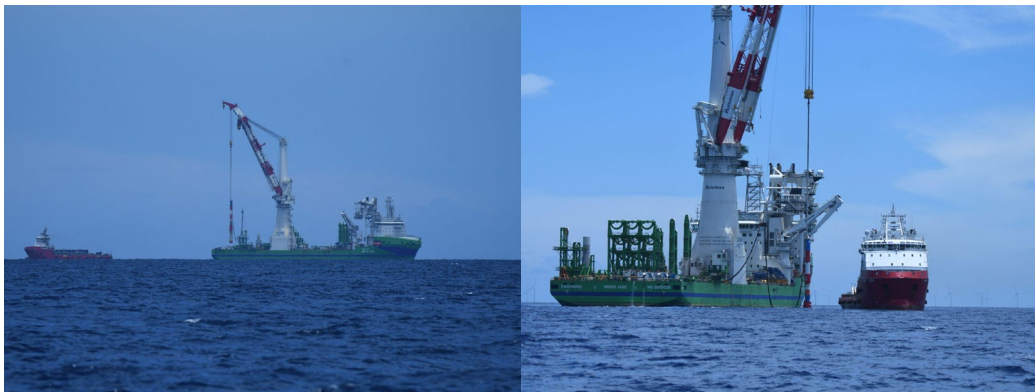
圖 2-26 海龍二號風場 HL21-D01 打樁情形
