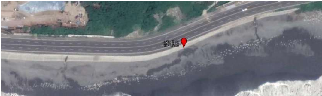
2018 年 9 月，部份消波塊被土砂覆蓋。
