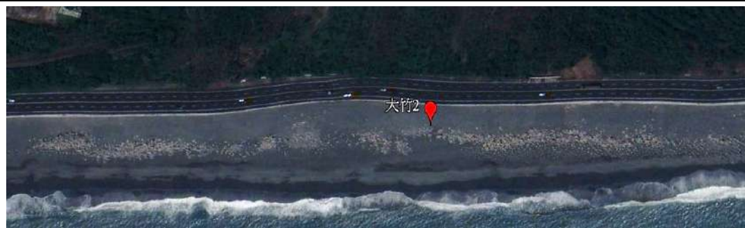
2017 年 4 月，道路工程結束，消波塊沿海岸線鋪設。
