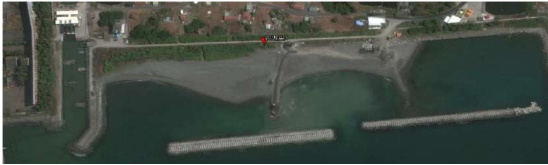
2013 年 2 月，離岸堤工程完工。
