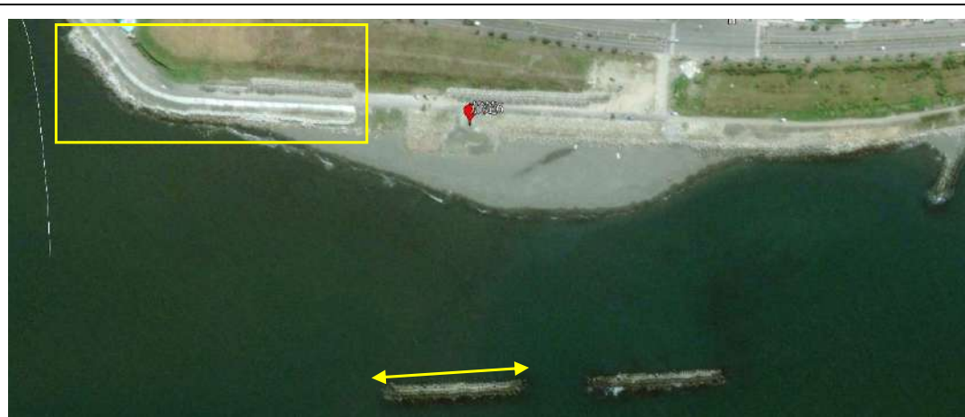
2012 年 3 月，新增離岸堤 (黃線示意)；左側海岸新增消波塊與水泥海堤 (黃框示意)。
