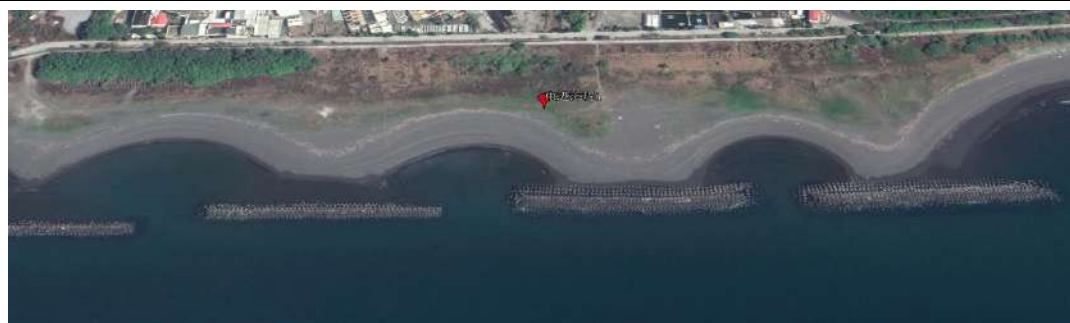
2021 年 3 月，Google Earth 最新圖像，可顯示目前紀錄最新的海岸線狀況，投放離岸堤後之海岸線有積沙的現象。
