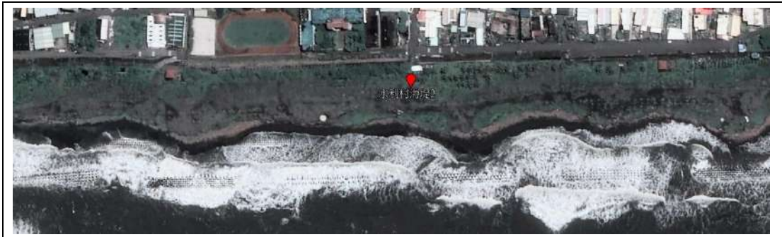
2016 年 8 月，所有投放之消波塊皆被土砂及植物覆蓋。
