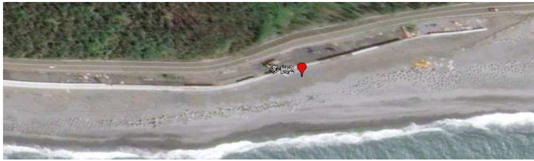
2016 年 7 月，道路工程。
