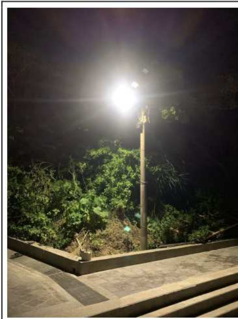
進沙灘前左側路燈，夜間
