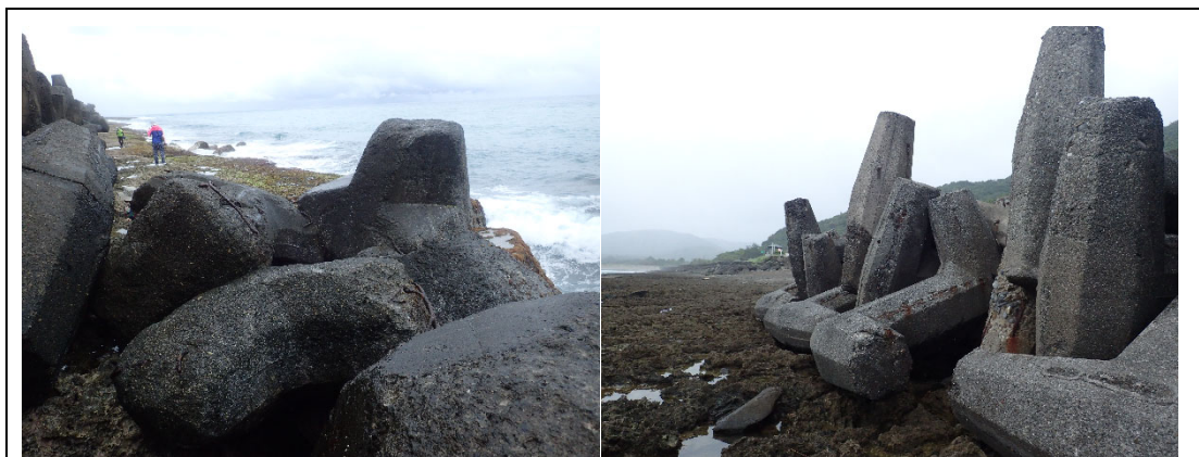
圖 92. 消波塊近照，形狀特殊，僅一處離海較近 (左、右圖)。
