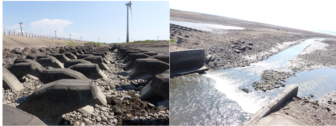
圖 48. 排列整齊的天允塊 (左圖)。鄰近樣區的排放出水口 (右圖)。
