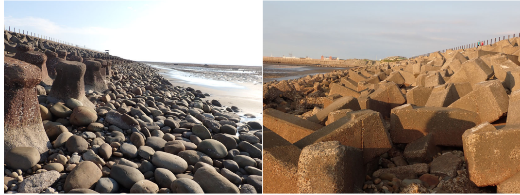
圖 44. 部分區域之消波塊底層大量放置礫石 (左圖)。近海堤處之消波塊類型不同，且呈不規則投放堆疊 (右圖)。
