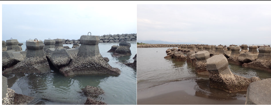
圖 84. 離岸堤與兩側投放之消波塊離海較近，故退潮時有大部分仍於水中 (左、右圖)。
