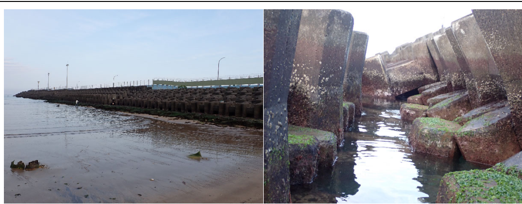
圖 28. 消波塊投放狀況近照 (右圖)，低潮時消波塊淹於水中的狀況 (左圖)。
