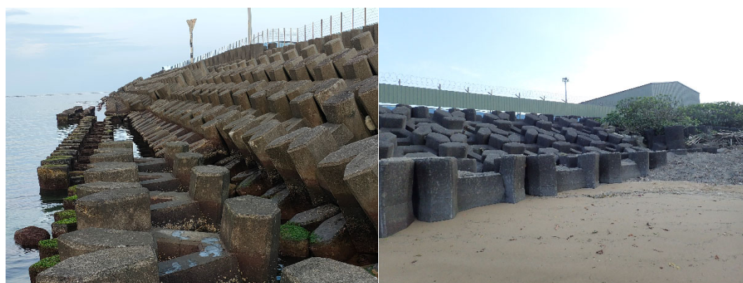
圖 27. 規則排列投放之消波塊，於低潮時仍有部分消波塊淹沒於水面之下（左圖）。接近岸邊，可見逐漸被土砂覆蓋的消波塊（右圖）。
