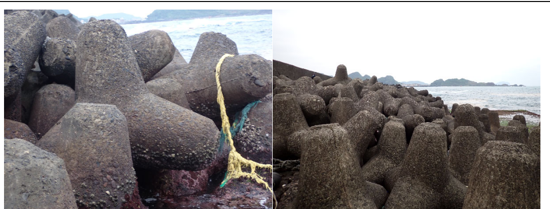
圖 20. 沿海堤堆疊投放之消波塊近照 (左、右圖)。
