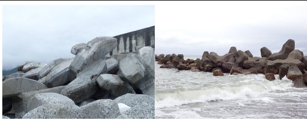
圖 120. 近陸區不規則投放之天允塊（右圖）。垂直於海岸線，不規則堆放之協克塊（左圖）。
