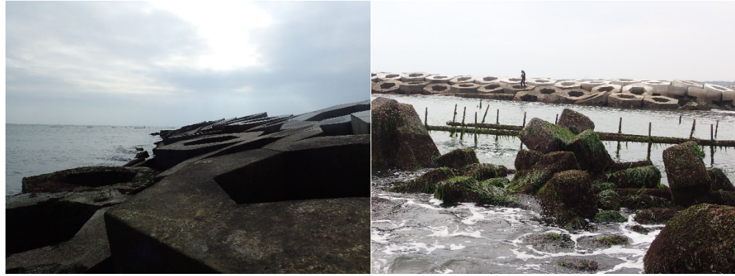
圖 72. 鼎型消波塊垂直海岸線投放，於低潮時部分仍於水面之下 (左圖)，三和塊生長大量藻類，與鼎型消波塊投放方式相同，但呈不規則散於海岸上 (右圖)。
