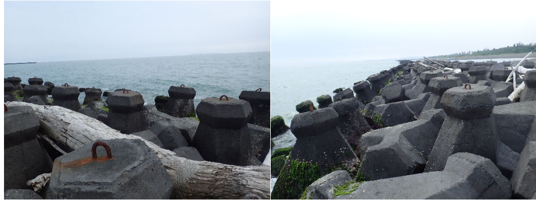
圖 80. 消波塊整齊堆疊排列，近海處的消波塊表面有藻類覆蓋，可能增加生物活動的範圍 (左、右圖)。
