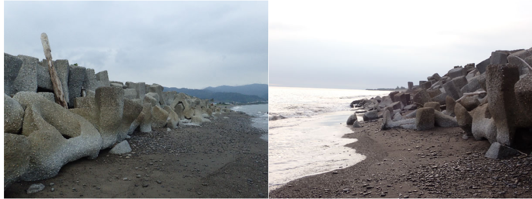
圖 88. 投放之消波塊於海岸線上之狀況，有些消波塊已經破裂崩解，部分則被土砂覆蓋 (左、右圖)。
