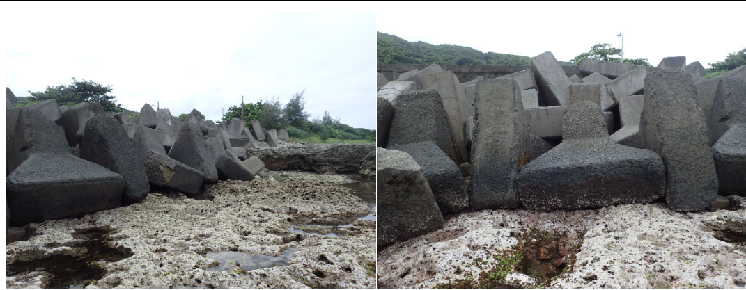
圖 96. 消波塊投放於岩礁之上，退潮時離海較遠（左圖）。消波塊近照（右圖）。
