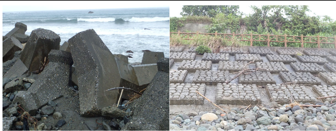
圖 116. 消波塊除了常見的林克塊之外，還有呈不規則切割之消波塊混合堆放 (左圖)。近岸處有方形水泥排列而成的水泥堤防 (右圖)。
