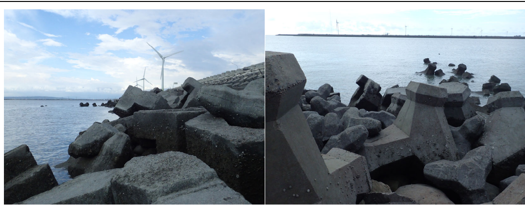
圖 52. 不規則投放之消波塊，近海處部分消波塊於退潮時間仍置於海中 (左、右圖)。
