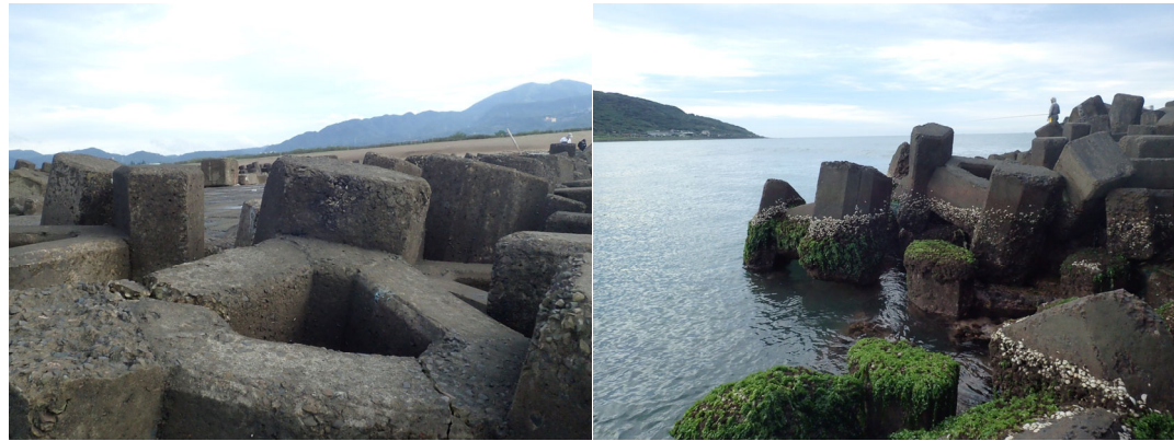
圖 8. 三腳鼎塊沿水泥平台不規則投放，且部分消波塊於退潮時仍有部分塊身淹沒於海水之下 (左、右圖)。
