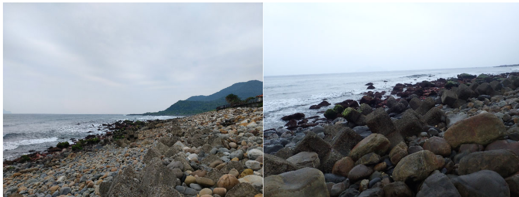
圖 103. 消波塊不規則的落在礫石堆中，部分消波塊邊緣已磨平或碎裂，顯示此處消波塊應已投放多年（左圖）。散落在礫石堆中之六腳塊（右圖）。
