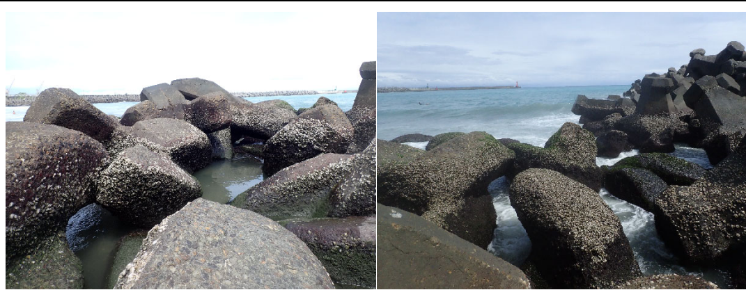
圖 108. 消波塊混雜投放，低潮時間仍有部分消波塊會被海水淹沒覆蓋 (左、右圖)。
