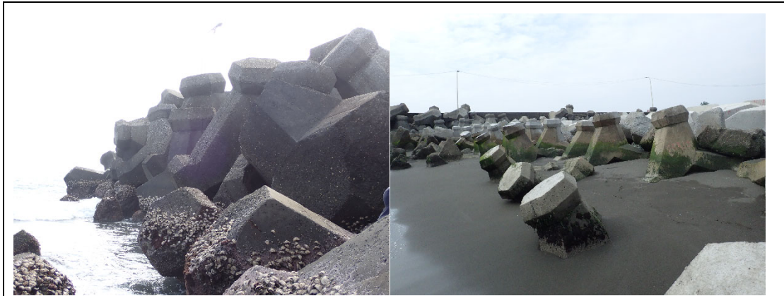
圖 76. 近海處之消波塊不規則推疊，於低潮時間仍有大部分區塊被海水覆蓋 (左圖)。部分消波塊本體被泥沙覆蓋，顯示此區泥沙淤積狀況嚴重 (右圖)。
