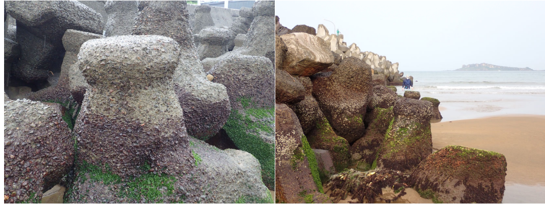
圖 12. 消波塊近拍 (左、右圖)，消波塊偏低的位置仍有藻類覆蓋，近海處的消波塊部分於退潮時仍淹沒於海水之下。
