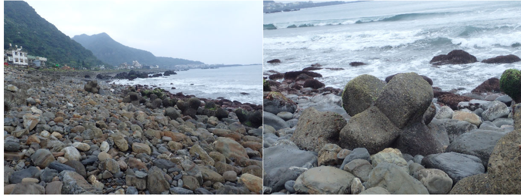
圖 104. 散落在礫石灘上的消波塊 (左圖)，銳角已被磨平之消波塊近照 (右圖)。
