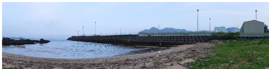
圖 26. 樣區全景紀錄。消波塊於排水道旁排列放置，底質為沙岸，近岸處有輕微淤積狀態。
