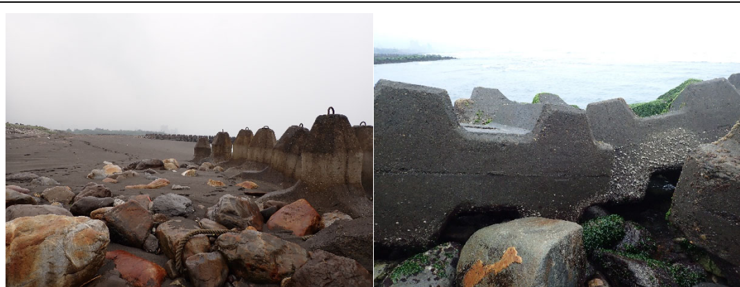
圖 100. 消波塊 (協克塊) 附近混有大型石塊 (左圖)，H 型消波塊底部有大型石塊 (右圖)。
