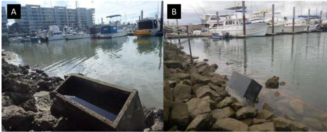
圖五、在澳洲湯斯維爾 (Townsville) 的人工海岸上放置水泥箱。並且比較開口朝內 (A) 與開口朝外 (B) 對生物多樣性的影響 (Waltham and Sheaves 2018)。
