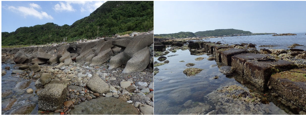
整齊排列的消波塊 (左圖)，近海區域有方塊狀水泥塊整齊排列成一道緩衝 (右圖)。
