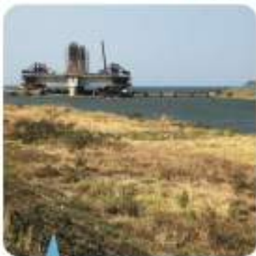
102 年所記錄到，正在興建的屏東四重溪福安大橋
