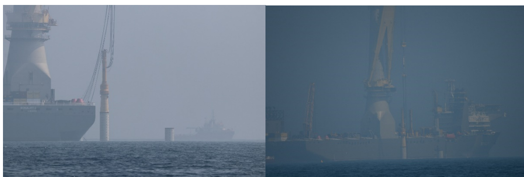
圖 3.3.3-15 施工船 BOKALIFT 2 打樁作業情形
