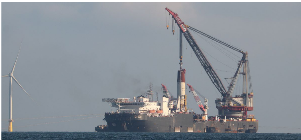
圖 3.3.3-21 施工船 DLS4200 準備打樁作業
