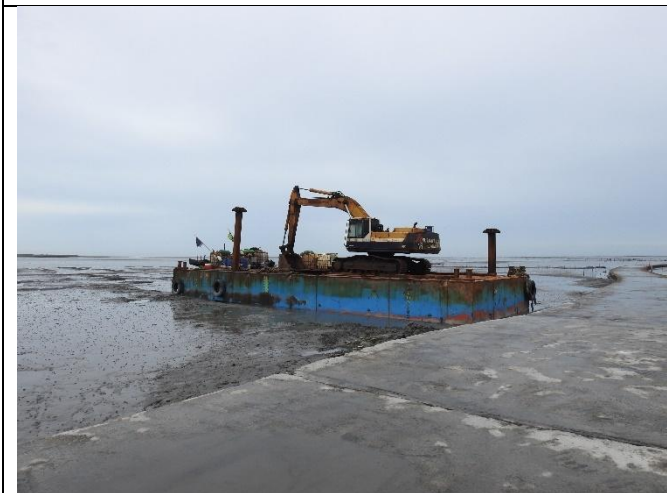
大城北區第二樣點進行清淤作業的怪手
